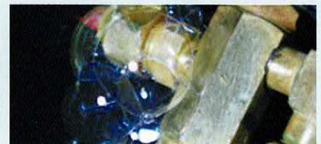
発泡液で漏えいを確認
